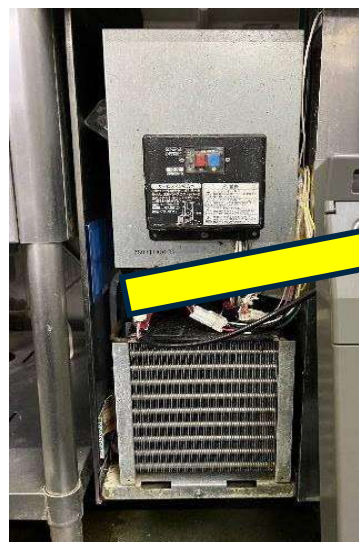
冷蔵庫制御部 (カバー外し装置内部の様子)
